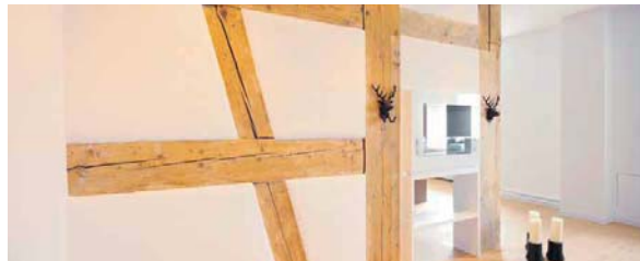
Die Riegelwände wurden wieder frei gelegt und sind nun modern inszenierte Zeugen des Alter des Gebäudes.
