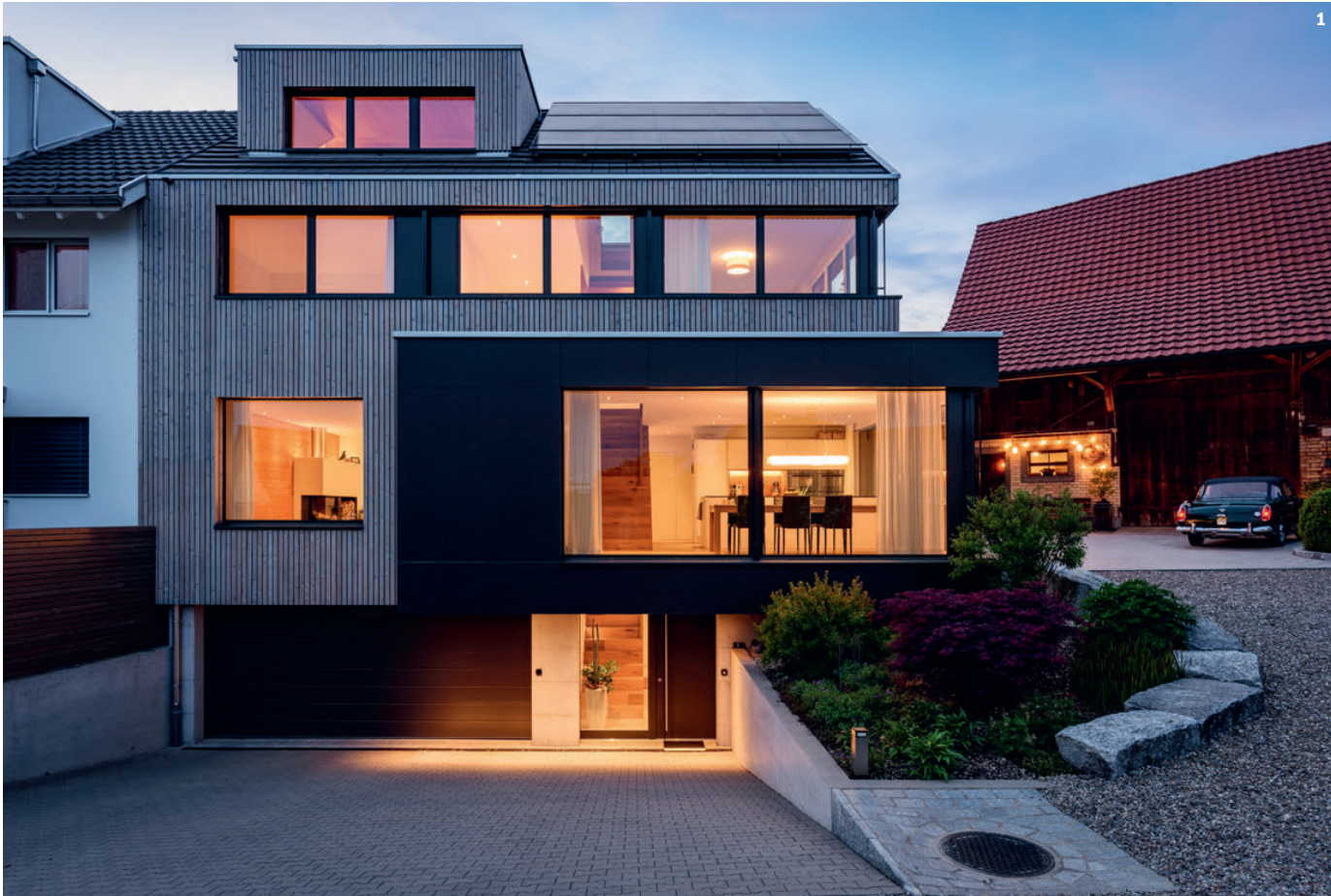
1 Einfahrt, Garage und Eingang befinden sich im Untergeschoss.
